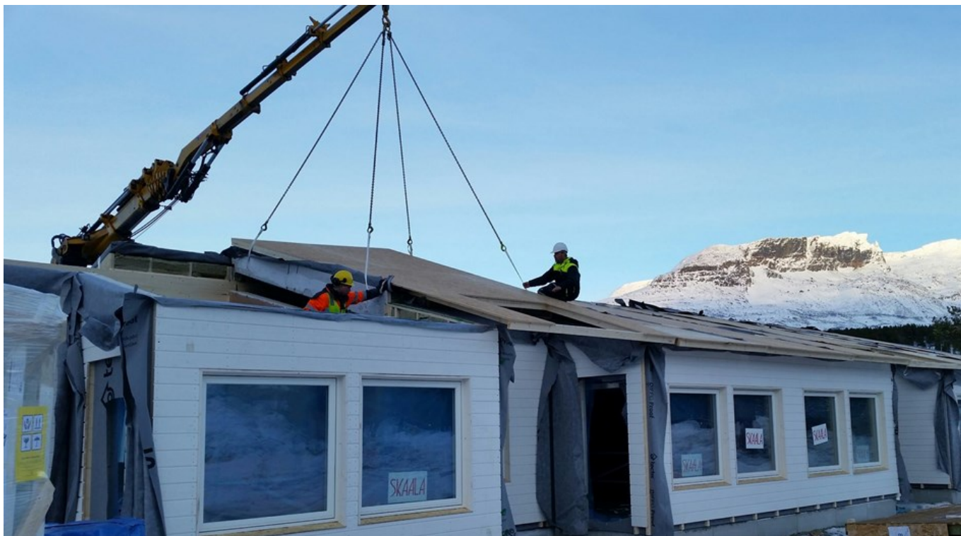
Det skal bygges flere boliger i Storfjord. Her fra boligprosjektet i Apaja. Foto: Storfjord boliger.
